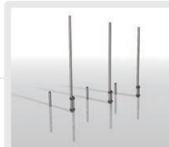
2 支柱パイプを立ち上げます
