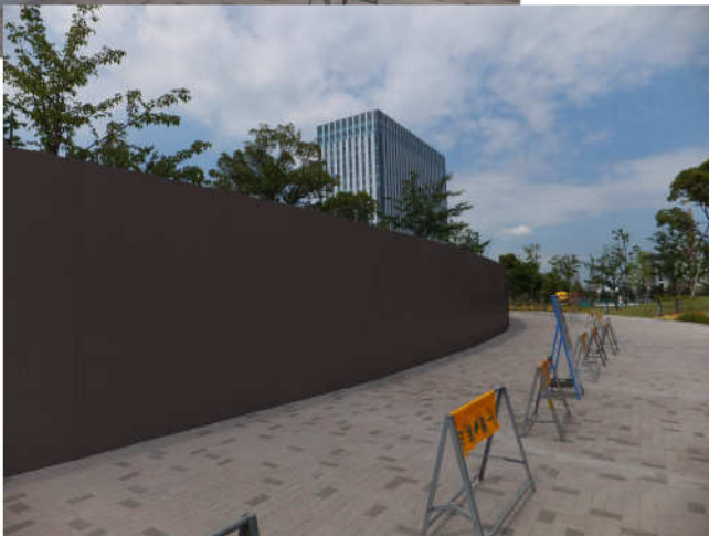
■都市部の景観色仮囲い設置イメージ
